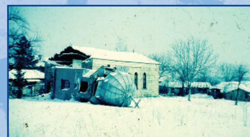
Dégâts sur l'église de Dirovo (Bulgarie) après un séisme
