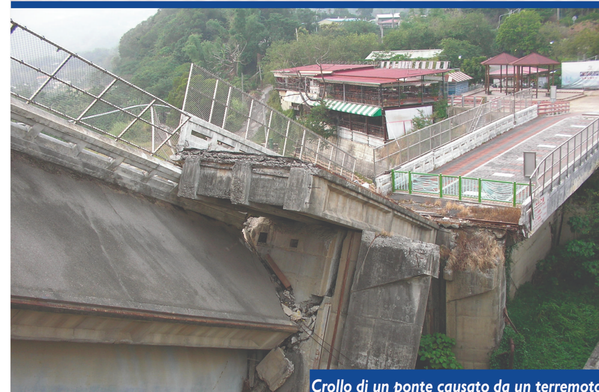
Crollo di un ponte causato da un terremoto
