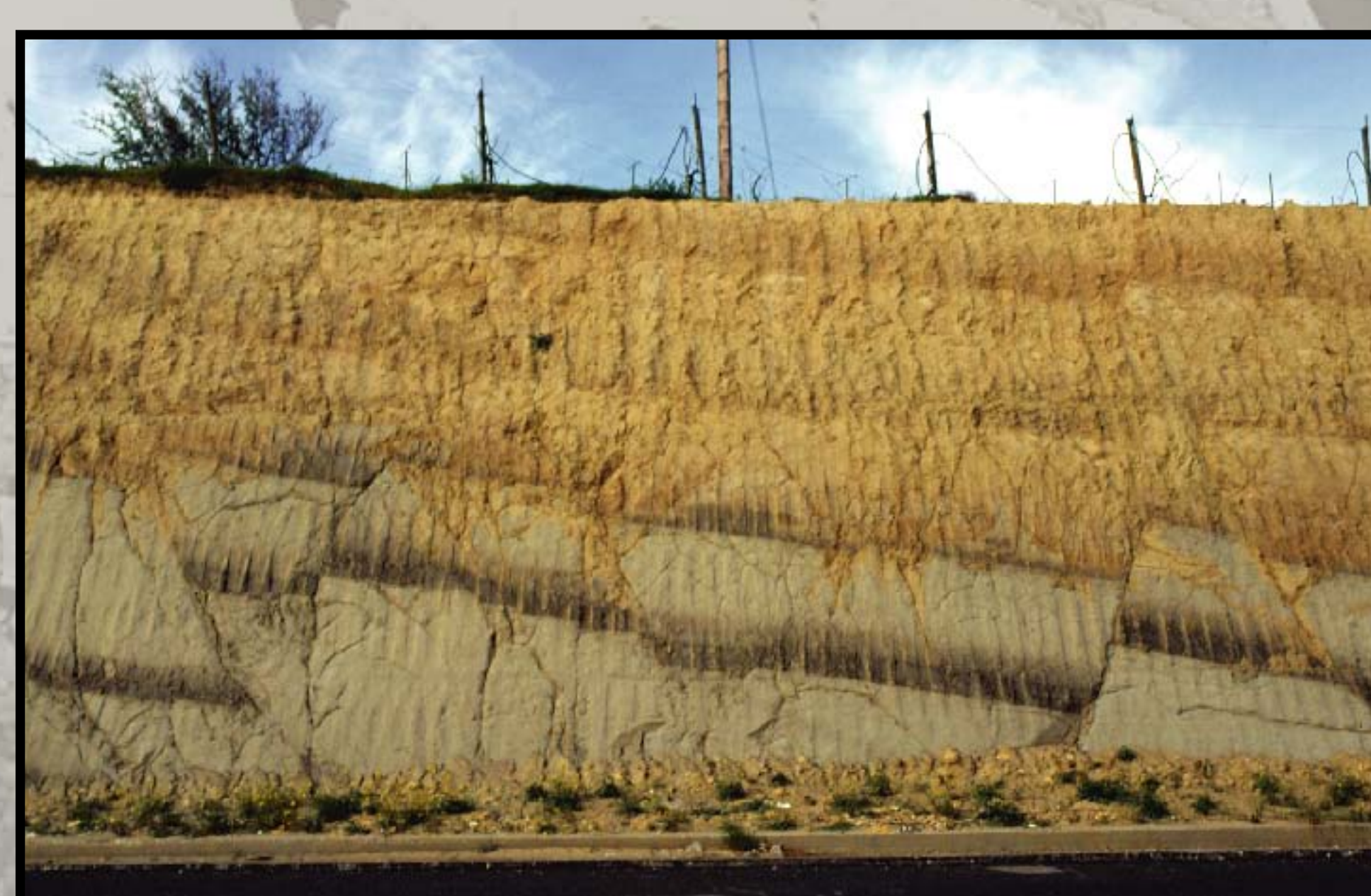
Ρήγματα έχουν μετατοπίσει μαλακά κήματα στην Κρήτη
